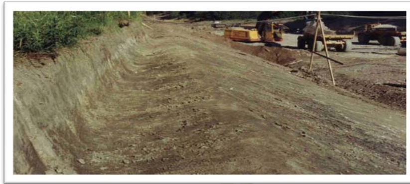
تصویر زیرسازی مناسب قبل از نصب GCL
