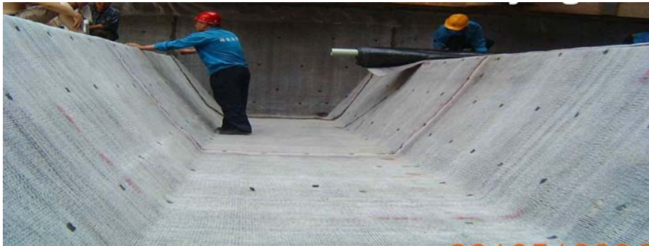
نصب GCL در دیواره‌ها استفاده از تفنگ هیلتی
